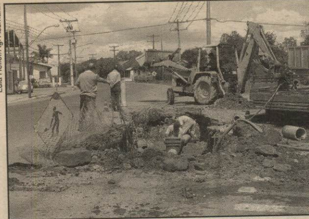
Obras no Arroio devem acabar com desabastecimento
