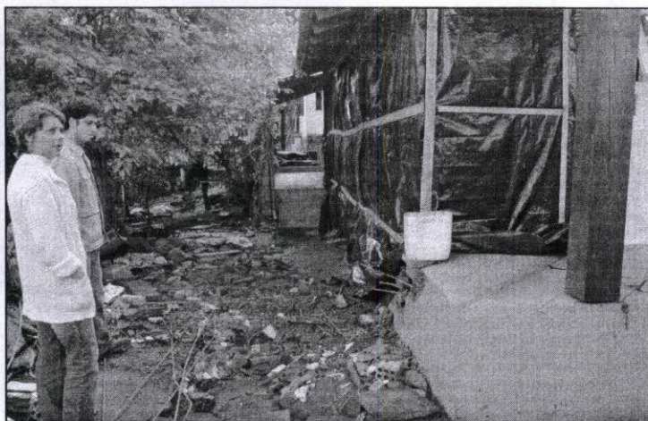
Forte enxurrada da madrugada de domingo levou parede e móveis de Ivânia
