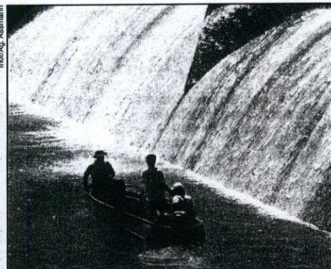
Comportas foram fechadas para facilitar o serviço
